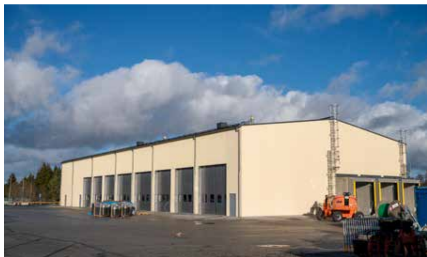
Arbetet går framåt med den nya teknikhallen som den tekniska avdelningen på LogE ska flytta in i under 2025. Foto: Josefin Sjöling
