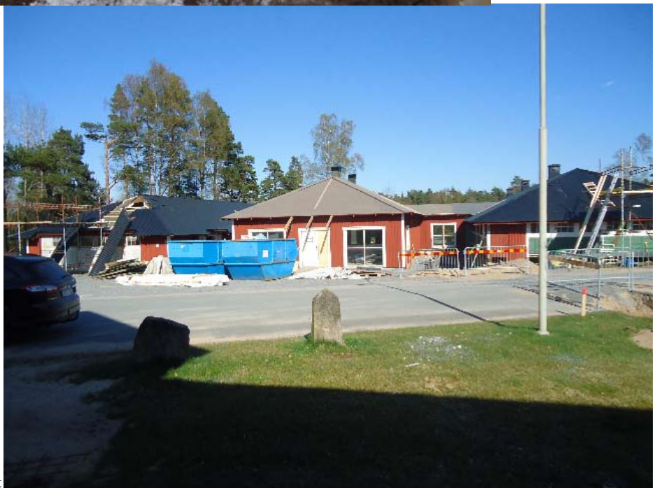
Bygget sett mot öster, april 2012.
