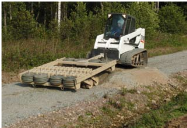
Test av maskinellt minröjningssystem och vält på uppdrag av GICHD.
