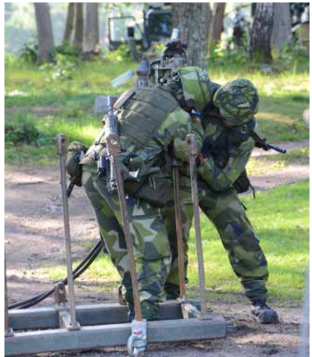
Förankring av brofäste.
