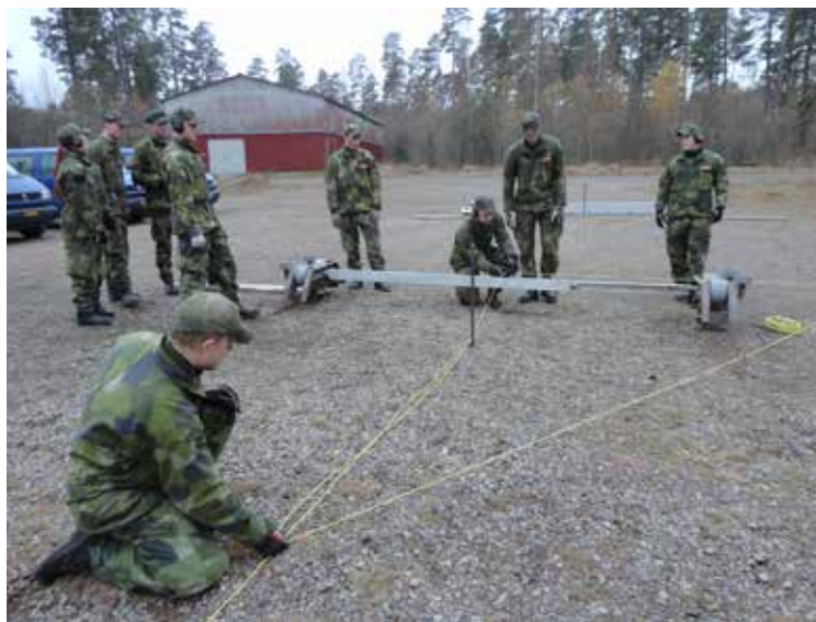
Inmätning av att lanseringsupplaget står vinkelrätt mot brolinjen för Krigsbro 4, KB 4.
