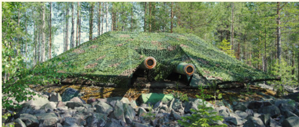
Tolv meter under jord ligger laddningsrummet där kardus och granat sammanfogades för transport med hiss i "stjälken" upp till kanonerna. Tornen i Siknäsbatterierna var handriktade och eldrören kunde höjdriktas var för sig.
