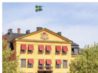
Värmväxlare utvinner värmen ur kasernens avloppsvatten – bland annat duschvatten.
