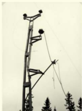
Av kontaktledningsstolparna totalförstördes endast en.
