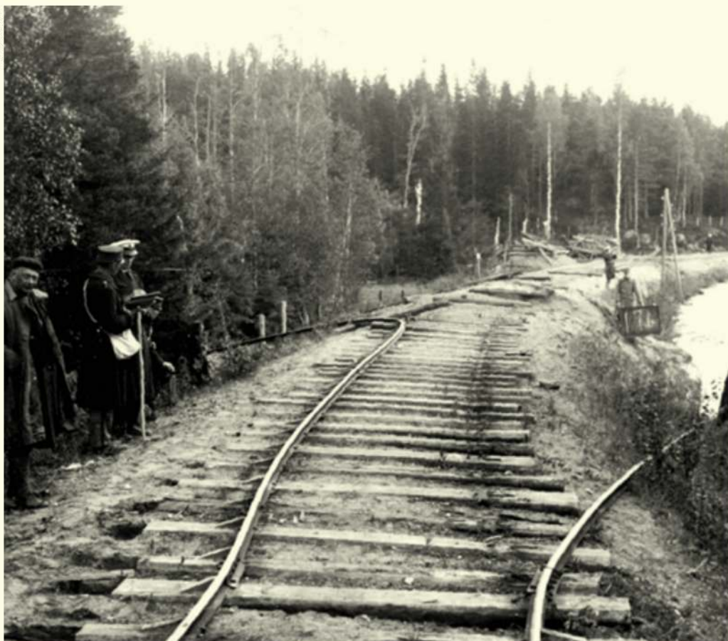
Vid sprängningarna slets rälerna i stor utsträckning loss från sliparna, och de närmast bomben slogs av. Så länge inte underbyggnaden skadats var reparationerna i allmänhet enkla med utbyte av förstörda räler och sliprar.
