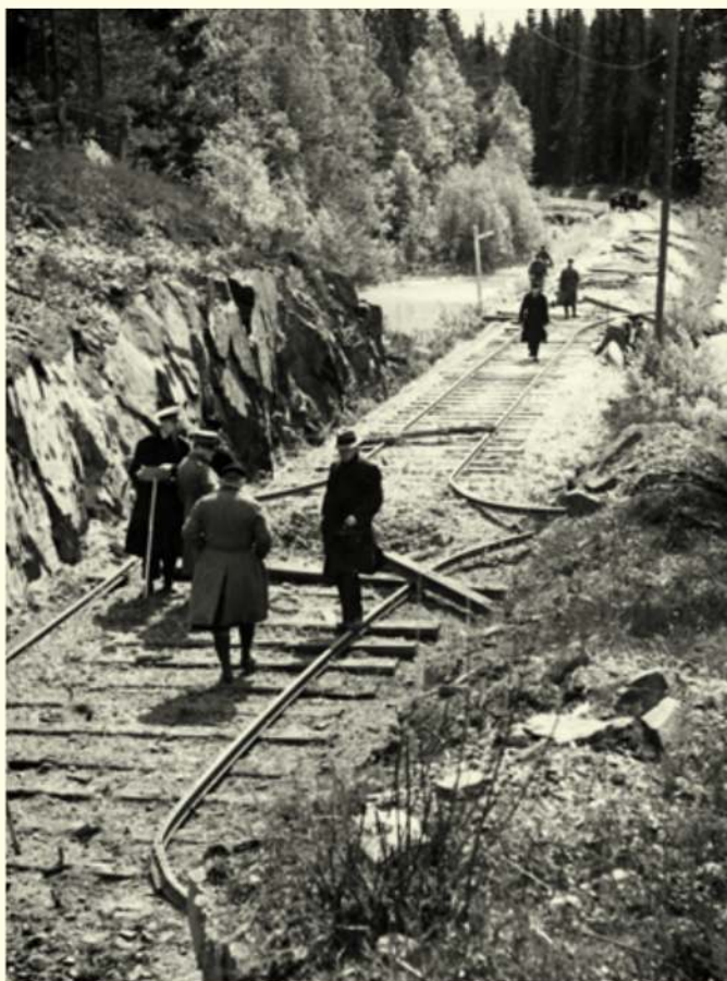
I bergsskärningar förstörde minbomber räler och sliprar, men åstadkom endast smärre skador i skärningens sida och banvallens berggrund.
