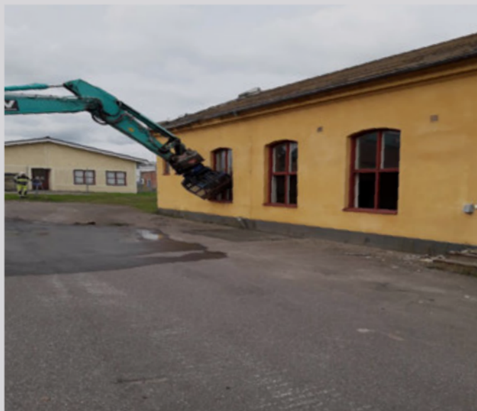
Den klassiskt gula byggnaden på T 2 rymde bland annat fordonsvård och rivs nu för att ge plats åt ett mer ändamålsenligt hus för Karstorp kompani.
