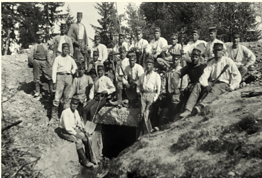
För de värnpliktiga som byggde Korvlinjen handlade det i allra högsta grad om manuellt arbete. Bakom ställningarna byggdes anslutningsvägar, som här mellan Näsby och Svalnäs.
