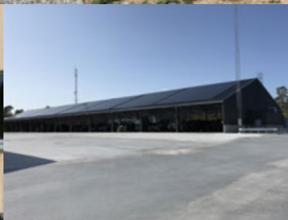
De två stolpladorna, som togs i bruk i våras, har solceller på skärmtaken med en toppoeffekt på 450 kW.
