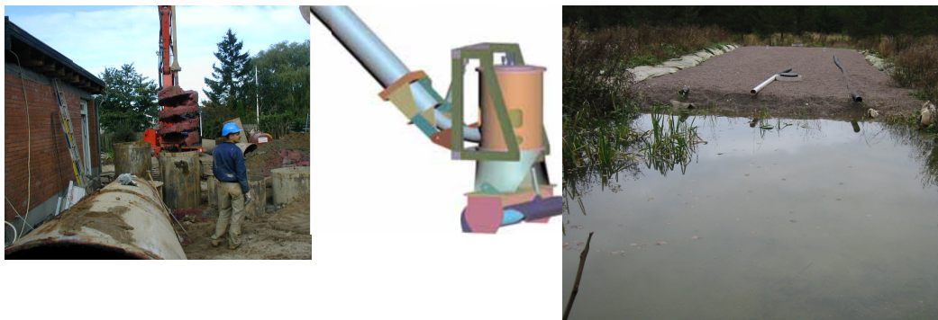
Figur 8.3. Bilden till vänster visar storformatsbörning varvid extraktion av förorenade jordmassor kan ske till djup överstigande normala grävdjup. Bilden i mitten visar positionsstyrd sugmuddring i sjömiljö. Bilden till höger visar anlagt sorptionsfilter för att minska utläckaget av bly och andra metallföroreningar i samband med urgrävning av ett större målområde inom ett av Försvarsmaktens nedlagda skjut- och övningsfält. [Helldén2013]
