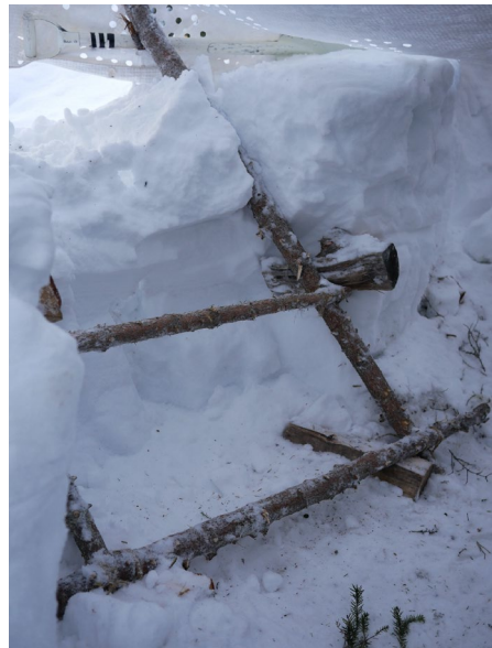
Bild 15.7 Vapenförvaring byggd av slanor och placerad i skydd mot väder och upptäckt under maskeringsnät. Bild: FMVE
