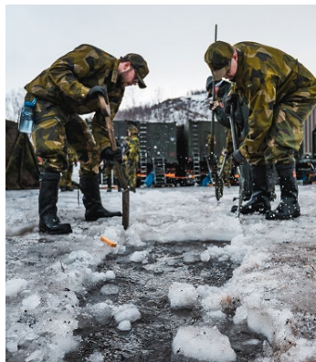
Bild 15.18 Vid längre gruppering på samma plats behöver du gräva dräneringsdiken. Bild: David Kristansen/Försvarmakten
