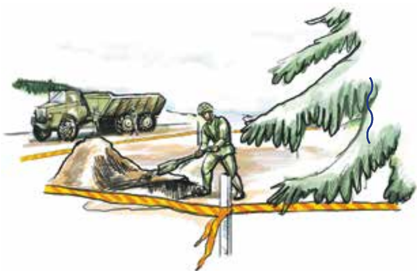
Bild 8.2. Exempel på avspärrningar av arbetsplats
