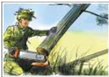
Röj undan träd och utnyttja dem som fyllnadsmassa
