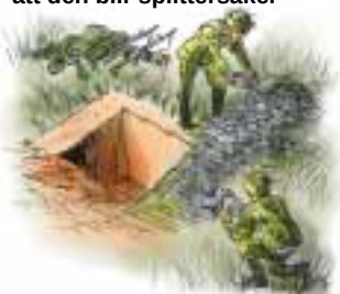
Bröstvärn utformas, en lätt lucka tillverkas och läggs intill värnet, maskering utförs
