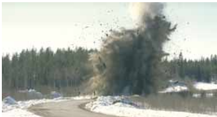
Sprängning av vägbank
