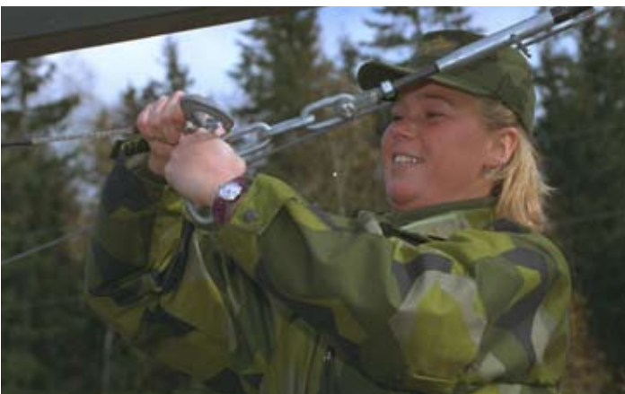
Arbete på TMR 40 länkmast © Försvarets bildbyrå
