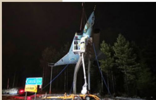
7 Med hjälp av en skylift säkras planet på fundamentet.
